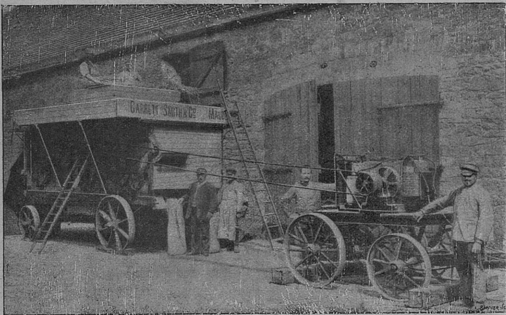
FIG. 3. — Battuseuse actionnée par une locomobile électrique.
