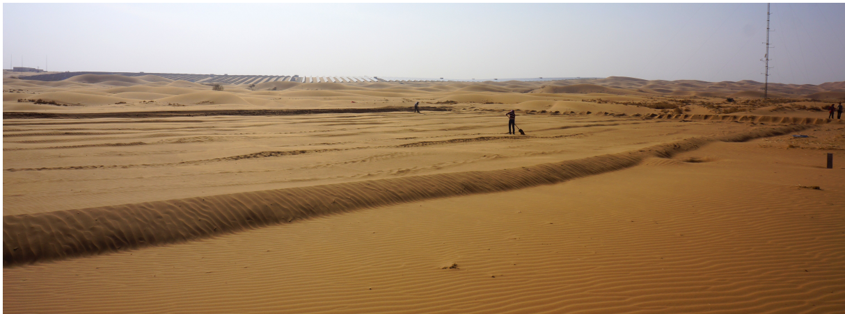
Préparation de la zone d'étude, phase d'aplanissement, le 10 Avril 2014 (© Narteau - IPGP)
